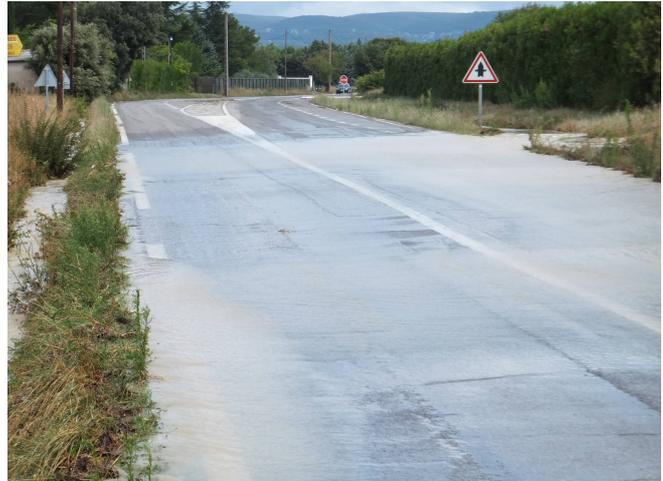
Route en Provence en mars 2015, 4 h après un orage : les fossés latéraux sont encore pleins de l'eau qui a ruisselé des champs situés sur la gauche et la chaussée est encore couverte d'eau
