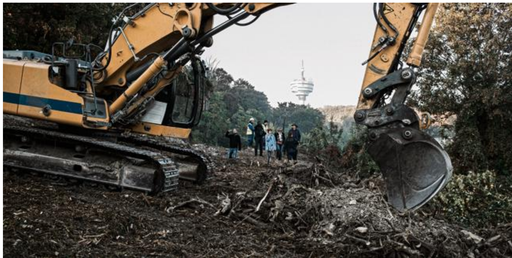
Les travaux en forêt de la Corniche des forts, le 10 octobre 2018. JULIEN DANIEL/MYOP
