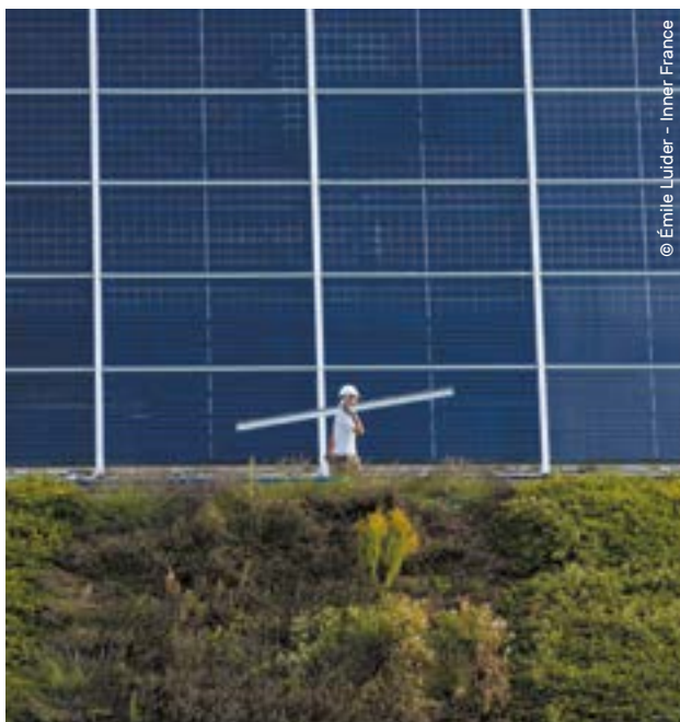
En 2017, Eau de Paris mettra en service la plus grande centrale photovoltaïque sur toiture d'Île-de-France (voir page 31).
