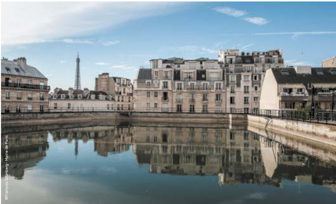
Réservoir d'eau non potable à Passy, 16 e arr.
