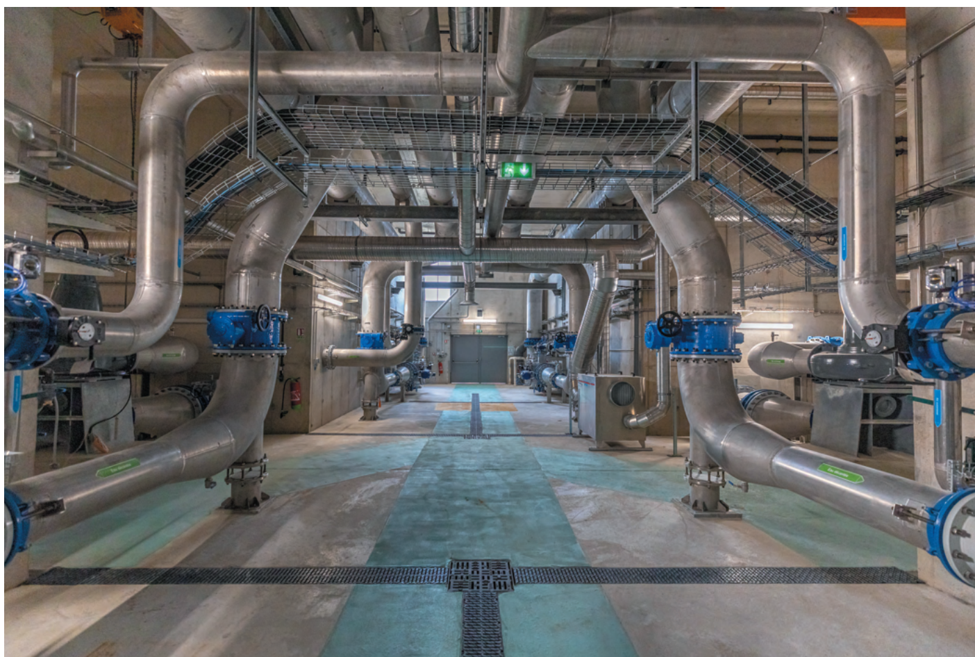
Galerie des CarboPlus, nouveaux bâtiments d'Orly © Didier Gauducheau
