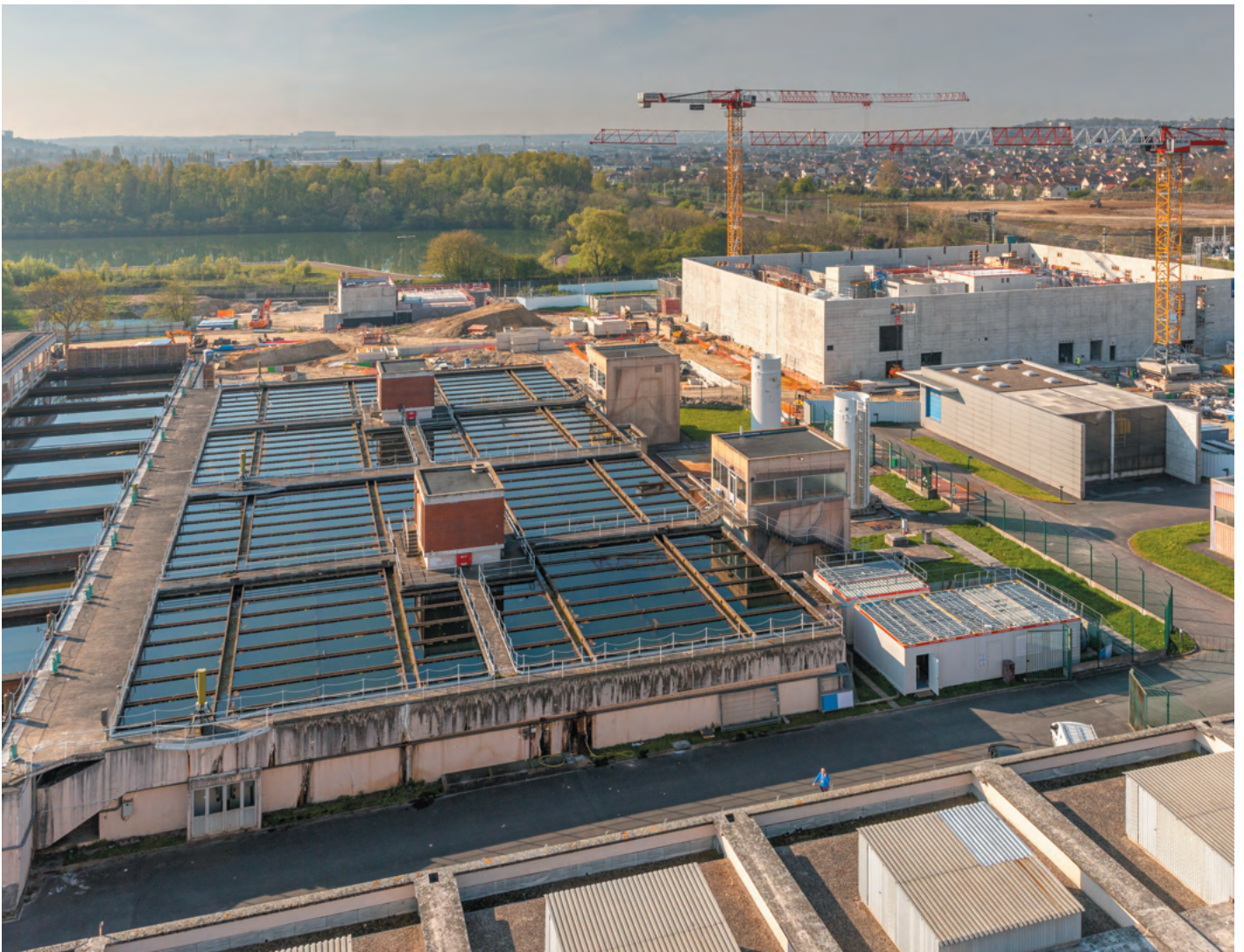
Chantier de l'usine d'Orly en avril 2021 © Didier Gauducheau
