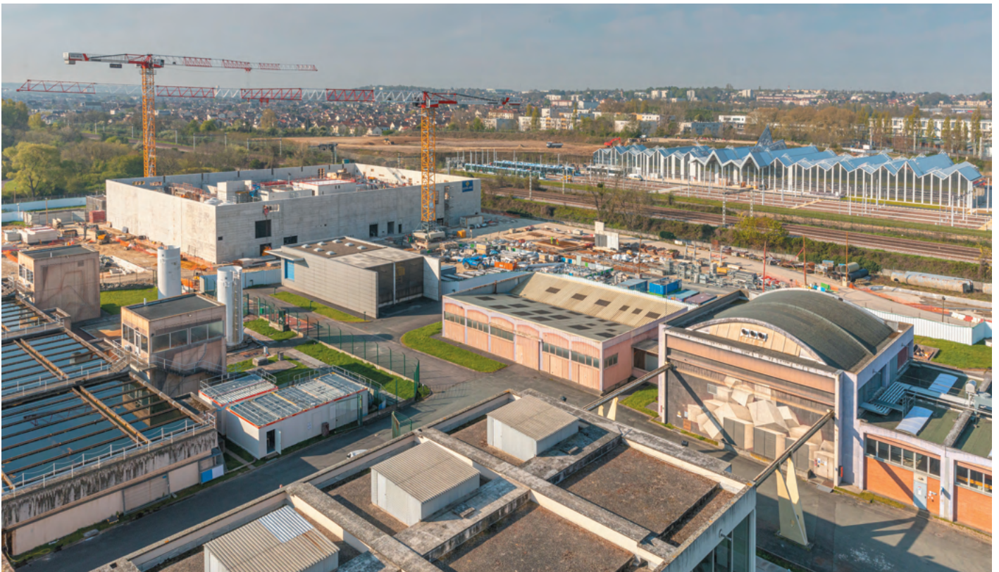
Construction de la nouvelle usine d'Orly © Didier Gauducheau
